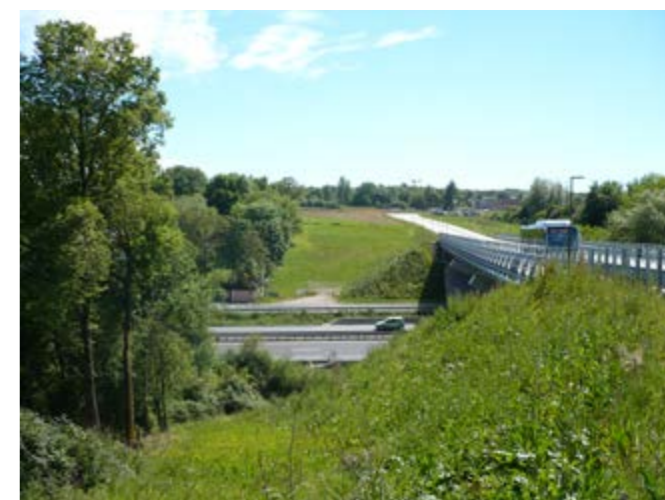
Vue du pont du TCSP et de la N118 (source TRANS-FAIRE, 2017)
